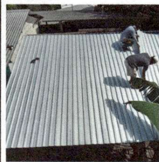
Foto1: sustitución de lámina por lámina troquelada aluzinc, con capote de lámina
