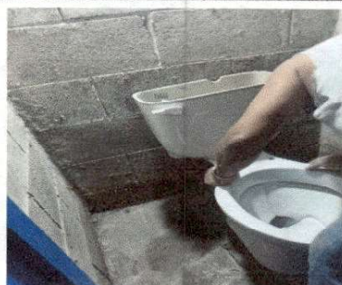
Foto 6. Sustitución de inodoro.
