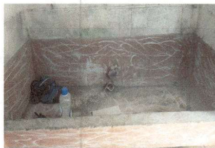
Foto 8: sustitución de llave de chorro y azujejo en lavamanos
