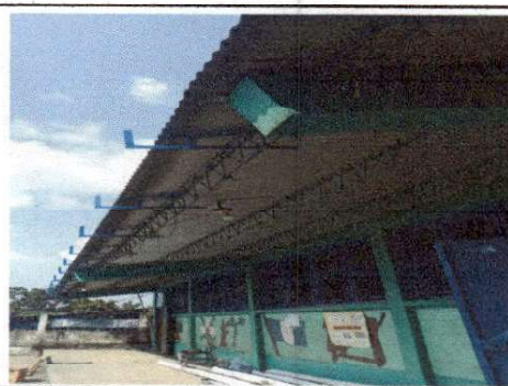
Foto 4. Reparación de bajadas de agua pluvial de tubo pvc
