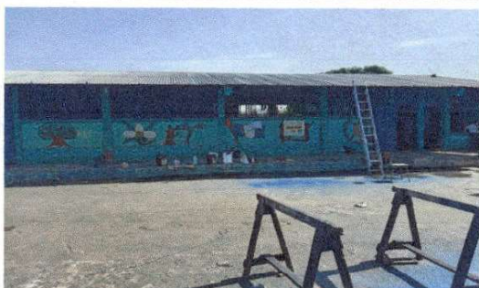
Foto 5. Pintura en muros exteriores e interiores
