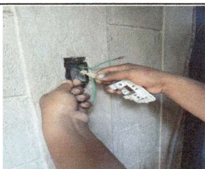
Foto 9. Sustitución de apagador
