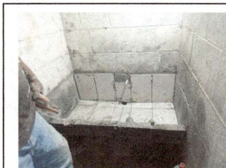
Foto 7. Sustitución de llave de mingitorio y colocación de azulejo
