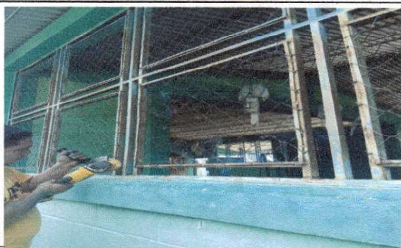
Foto 3: Mantenimiento de estructura de metal de ventanas
