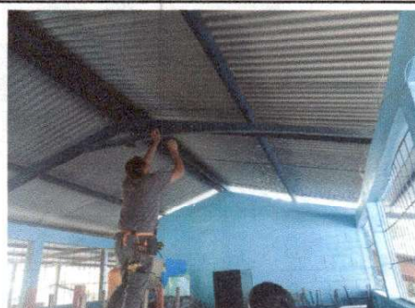
Foto 10. Reparación del cableado eléctrico
