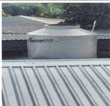
Foto 11. Sustitución de depósito de agua.
